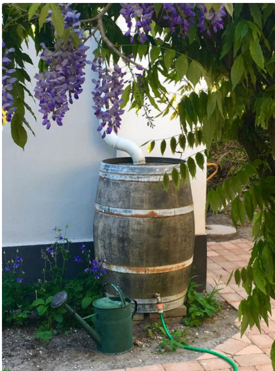
Figur 16. En regnvattentunna med utloppsslang och ventil. Illustration: Platsförvattnet.se
