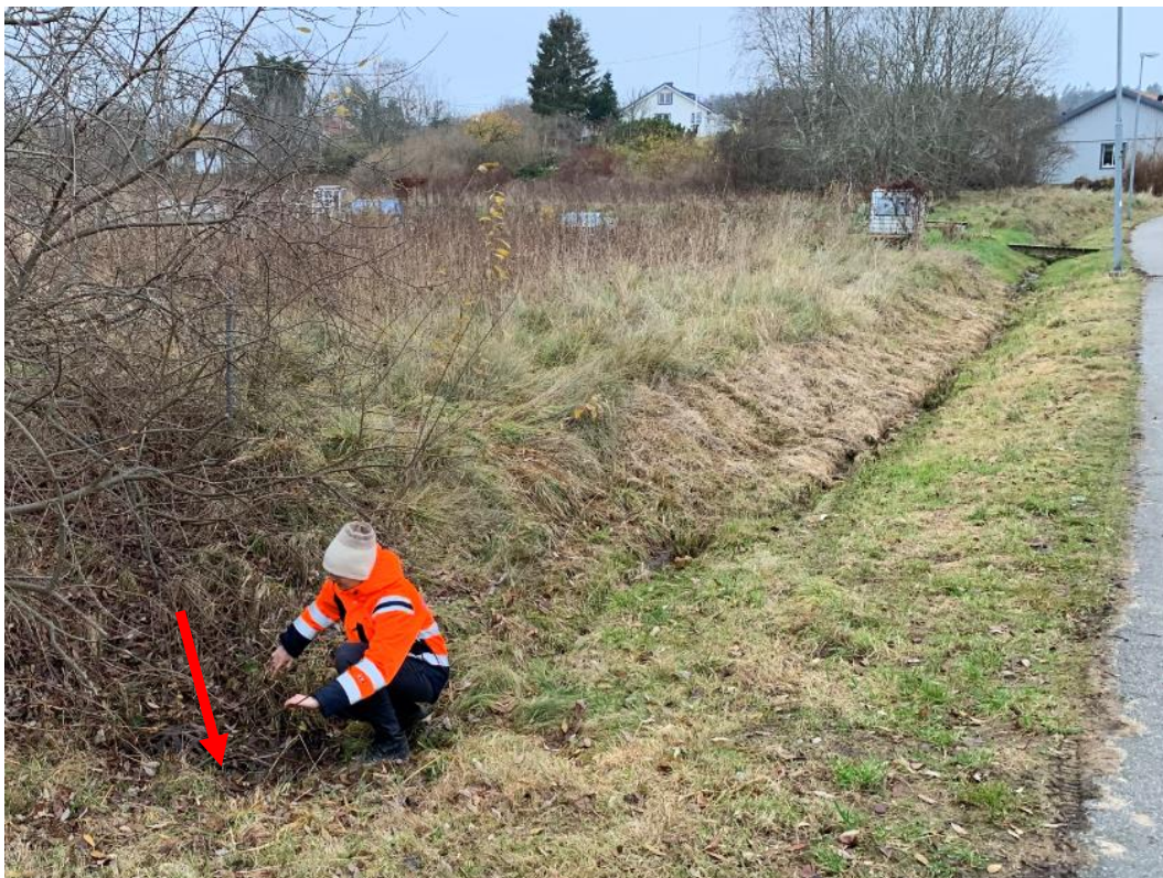
Figur 6. Befintligt dike och kupolbrunn, planområdets norra del. Kupolbrunn markerad med röd pil
