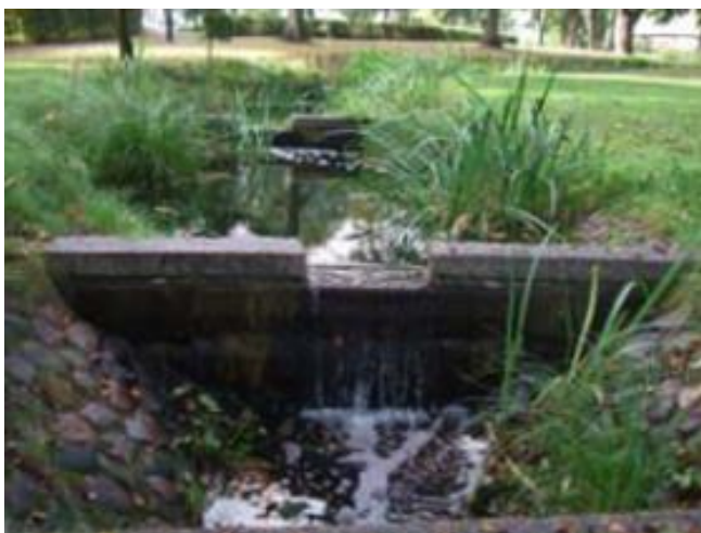
Figur 14. Dike med dämnen som bromsar vattnet.
